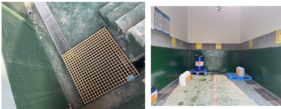
危险废物暂存间废液收集池
