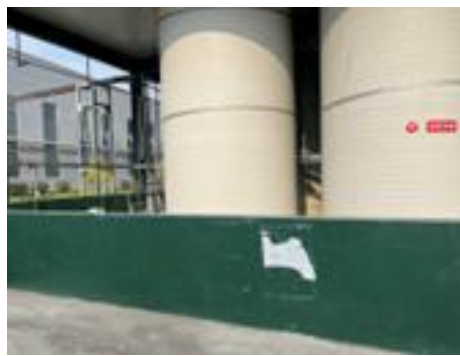
浓碱储罐区围堰
