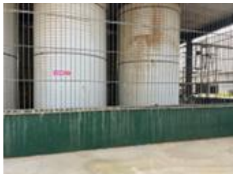
浓酸储罐区围堰
